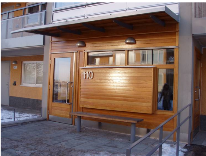
Entrépartierna har byggts om med välisolerade och täta ytterdörrar.
