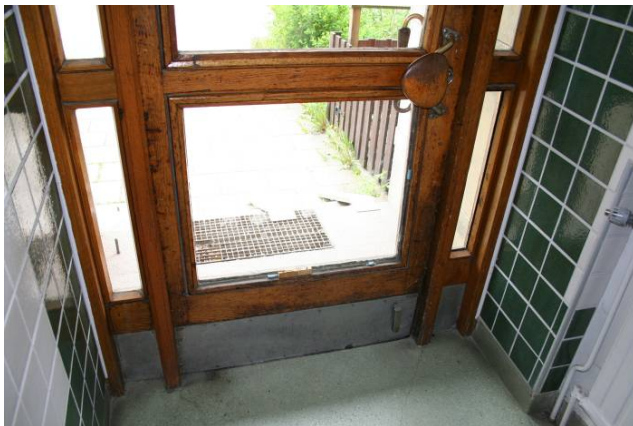
Ytterdörrar i uppvärmt vindfång har englasfönster.
