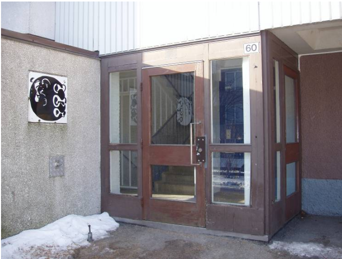
Ursprungliga entrépartier var oisolerade och hade 1-glasfönster.
